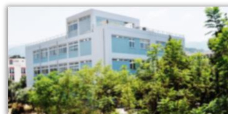
Κτήριο Επέκτασης Τμήματος Χημικών Μηχανικών
