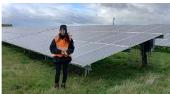
Η Έφη στο Elms Solar Farm
